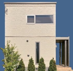
西12条南34丁目 分譲住宅1号棟
