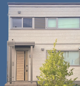
西20条南5丁目 分譲住宅1号棟
