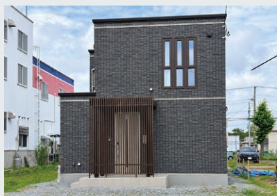
※内観・外観写真2026年7月撮影
